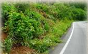
林道の法面の掘り起こし
